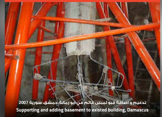
تدعيم و اضافة قبو لمبنى قائم في ابو رمانة، دمشق، سورية 2007 Supporting and adding basemet to existed building, Damascus
